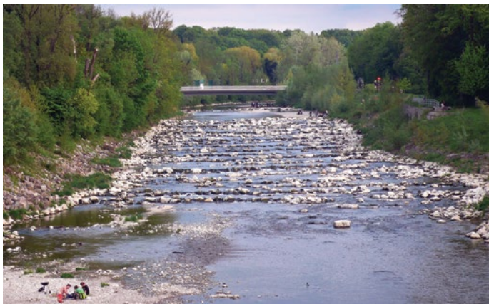
Obr. 7. Balvanová rampa v korytě revitalizované řeky Wertach v Augsburgu, která v roce 2006 nahradila technicky nevhovující jez Goggeles. Pohled v roce 2013 (foto T. Just)
