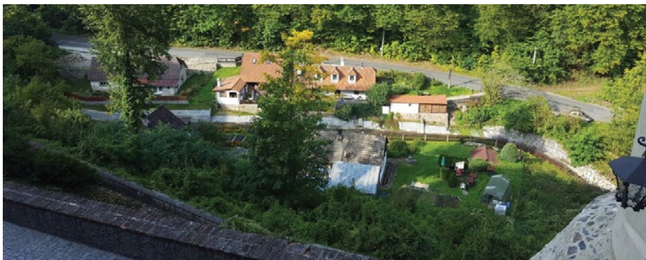
Stejný úsek Brtnického potoka po provedené rekonstrukci (foceno z hradu). Návrh rekonstrukce musel respektovat požadavky Národního památkového ústavu z důvodu situování stavby v prostoru národní kulturní památky hrad Český Šternberk. Úprava svým provedením odpovídá historické podobě z počátku 20. století
