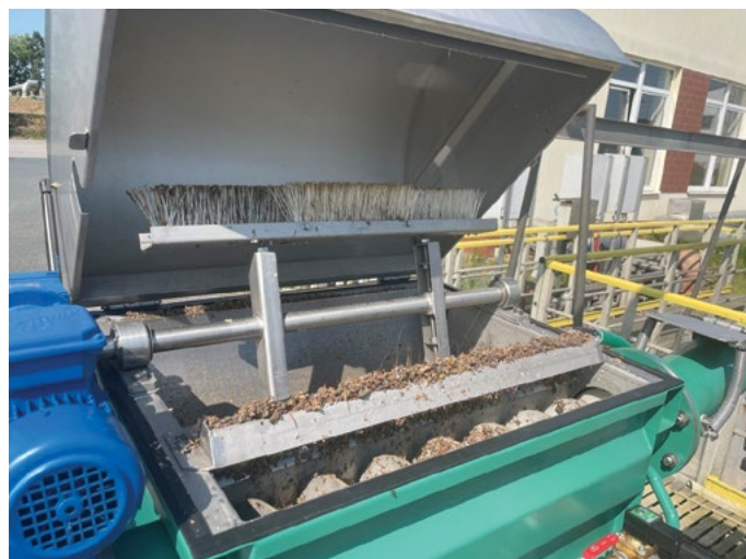
Obr. 1. Stírané válcové síto – SVSLS, zařízení s mikro sítem 0,3 mm, Fontana R, s. r.o. [11]
