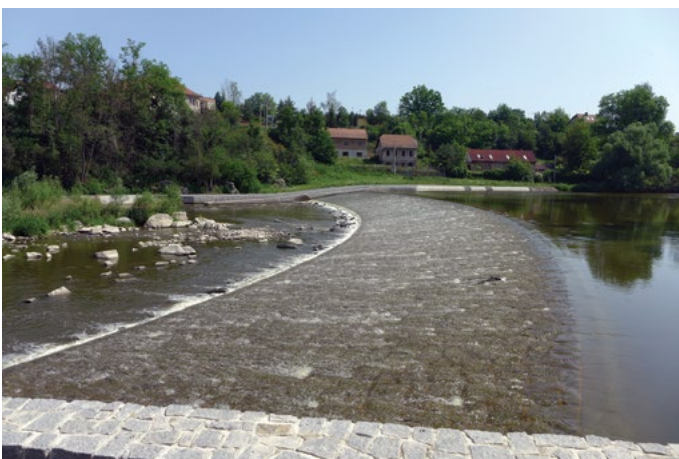
Obr. 5. Jez v Podělusích na Sázavě v roce 2019, po rekonstrukci (foto T. Just)
