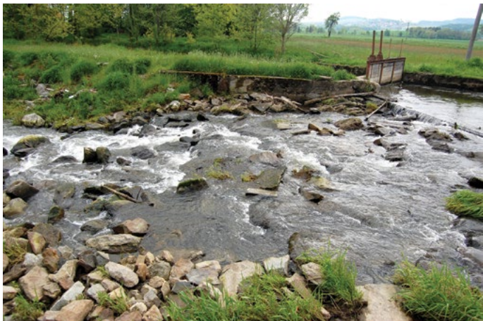
Obr. 1. Samovolná renaturace jezu Rohozno na Úhlavě (foto D. Fiala)
