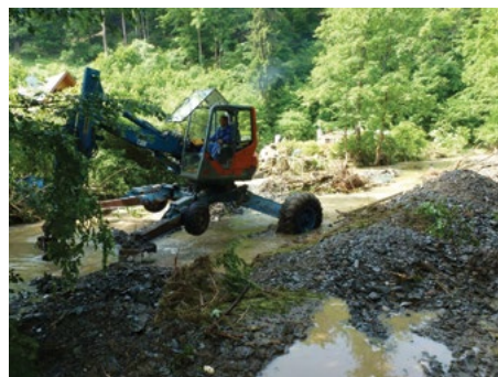
Odstraňování sedimentu z koryta Zahořanského potoka v k.ú. Davle v úseku ovlivněném vzdutím Vltavy
