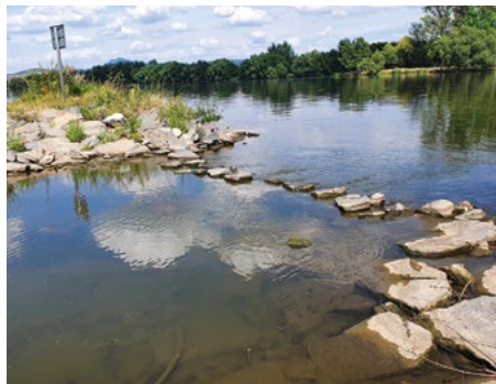
Obnovené napojení tůně na Labe
