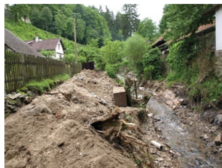
Koryto Brtnického potoka (levobřežní přítok Sázavy) v intravilánu městyse Český Šternberk po zahájení zabezpečovacích prací, které spočívaly zejména ve zprůtočnění koryta a stabilizaci nádrží
