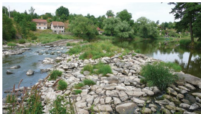
Obr. 4. Jez v Podělusích na Sázavě v roce 2014 (foto T. Just)
