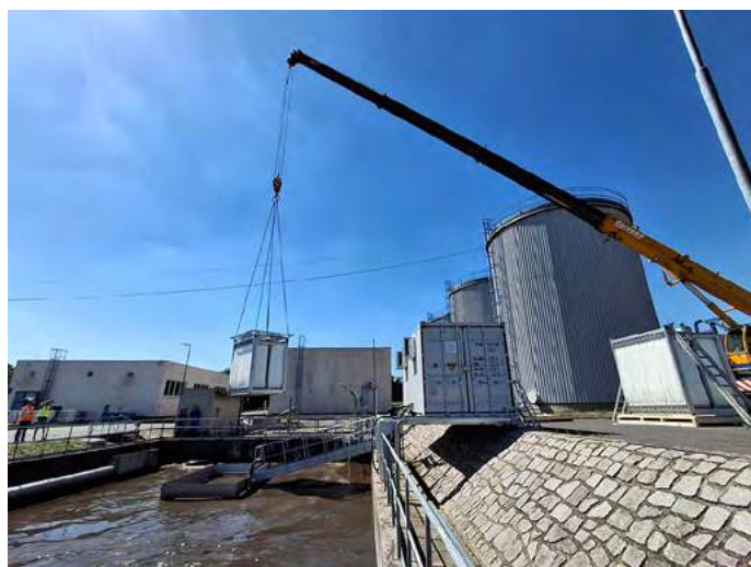
Umísťování zařízení ZeeLung MABR v lokalitě PČOV Čertousy
