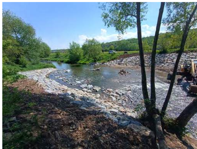
Obr. 2. Stavební práce na revitalizaci dolního stupně
