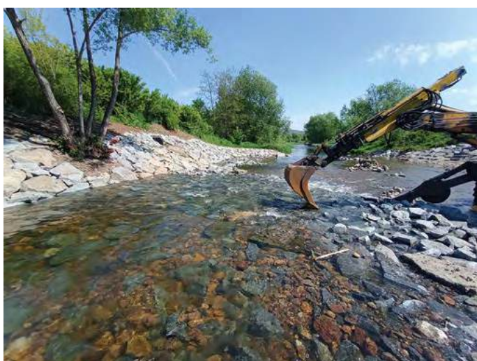
Obr. 3. Stavební práce na revitalizaci dolního stupně
