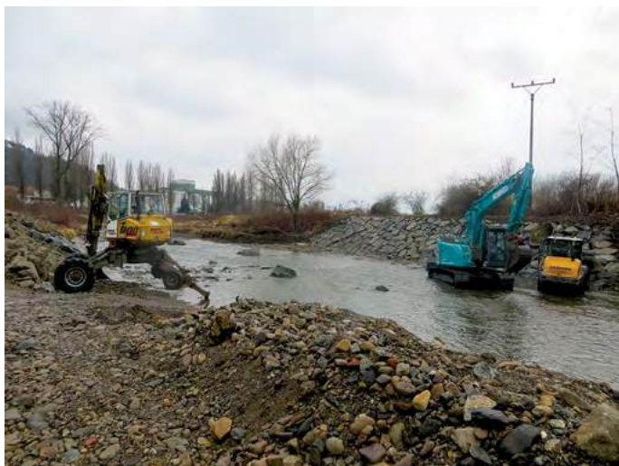
Obr. 1. Stavební práce na revitalizaci horního stupně
