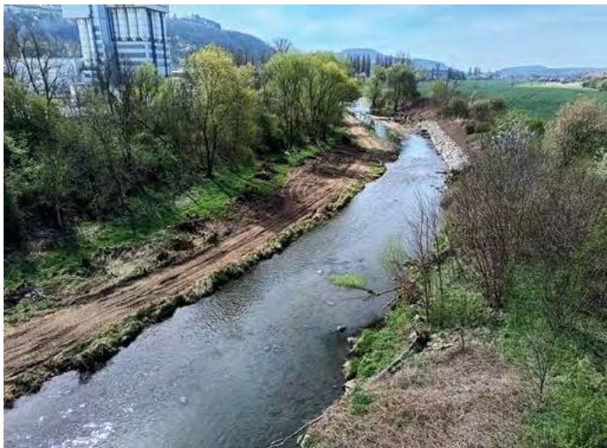
Obr. 5. Revitalizace levého břehu
