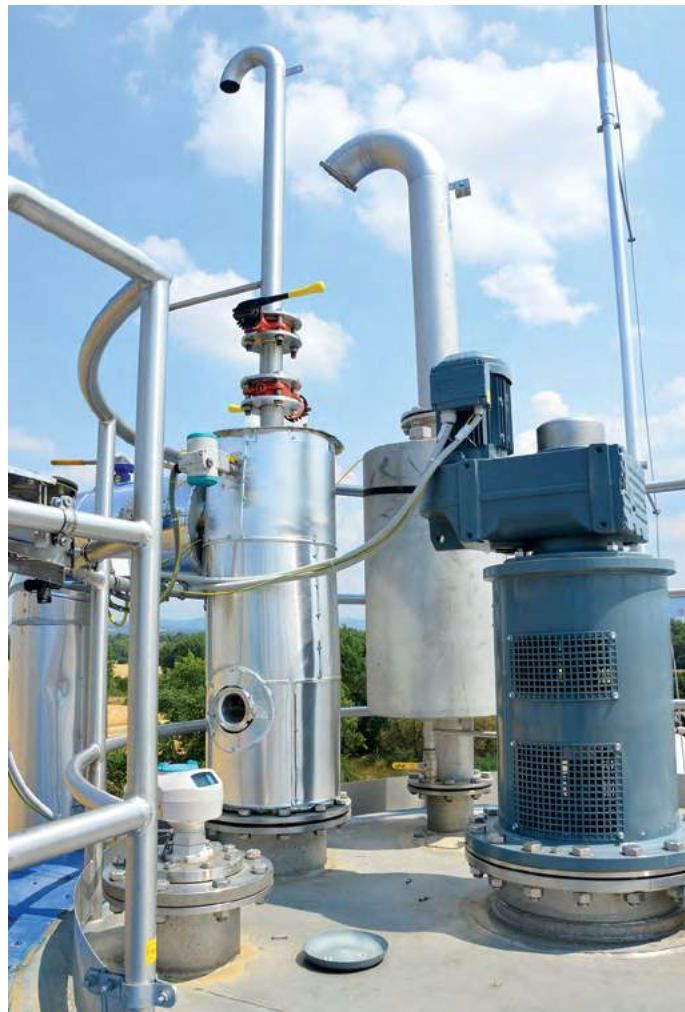
Obr. 1. Montáž kapalinové pojistky a jímáče bioplynu na víku vyhnivací nádrže
