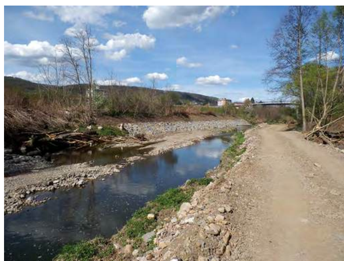
Obr. 4. Revitalizace levého břehu
