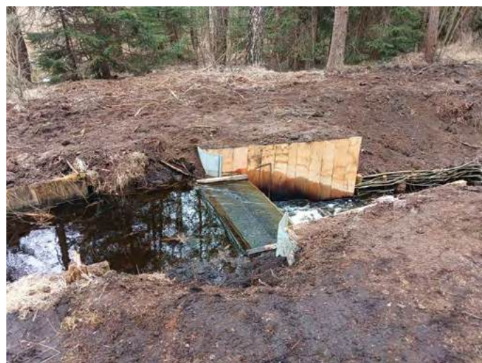
Obr. 2. Na Borkovických blatech byl prezentován především způsob zadržení vody v území prostřednictvím vzdouvacích objektů na původně odvodňovacích kanálech
