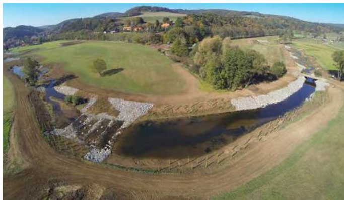
Nahoře a vlevo: Loděnice Nenačovice, průběh stavby. Zřejmá je bohatá výsadba dřevin a kamenitý skluz
