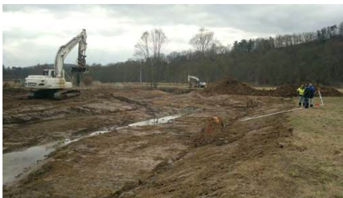
Nahore a vpravo: Loděnice Nenačovice, průběh stavby. Cílem je koryto rozšířit a rozvolnit
