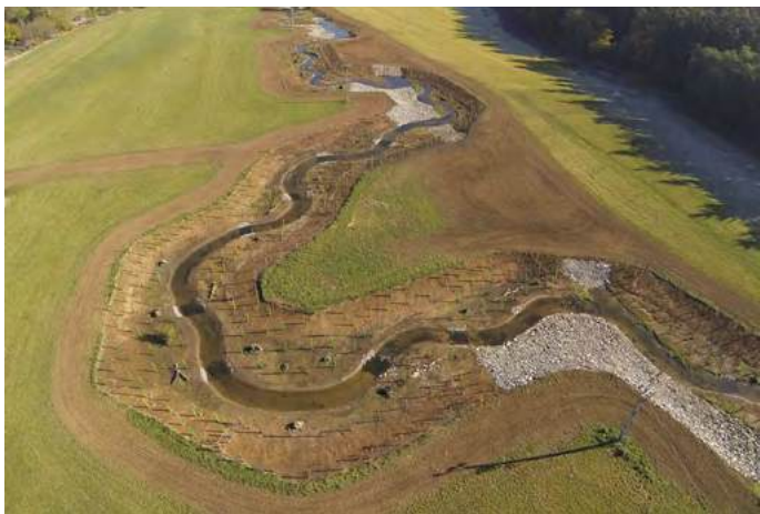
Nahoře a vlevo: Loděnice Nenačovice, průběh stavby. Zřejmá je bohatá výsadba dřevin a kamenitý skluz
