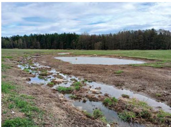
Obr. 3. Na levostranném přítoku Jetětického potoka u Stehlovic (okr. Písek) byla k vidění další revitalizační akce spočívající ve vytvoření mělkého revitalizačního koryta a tůň
