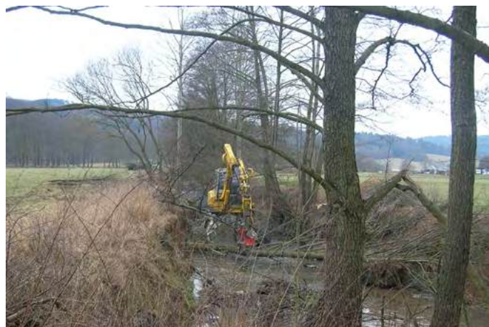
Nahore a vpravo: Loděnice Nenačovice, průběh stavby. Cílem je koryto rozšířit a rozvolnit
