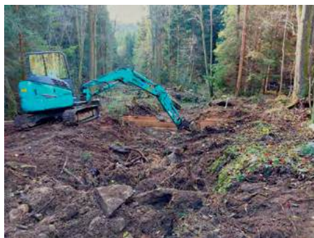
Realizace dřevěných přehrážek a vymělení
