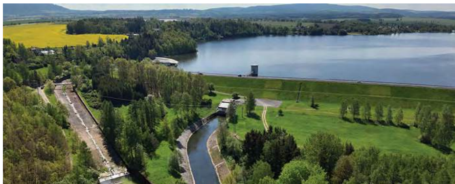
Obr. 1. Celkový pohled na VD Jesenice
