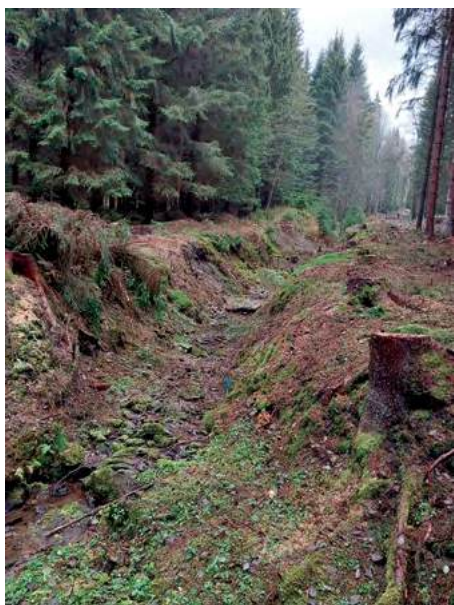
Koryto Jodlova potoka před realizací
