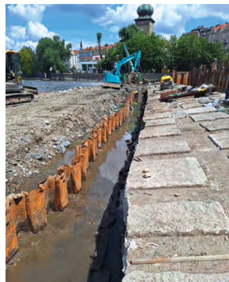
Prostor odtrhové hrany s původní štětovou stěnou
