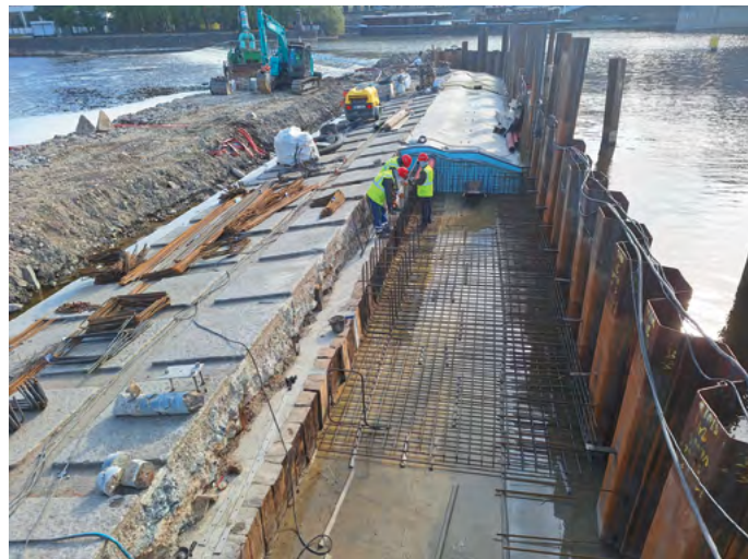
Vázání výztuže před betonáží předpolí
