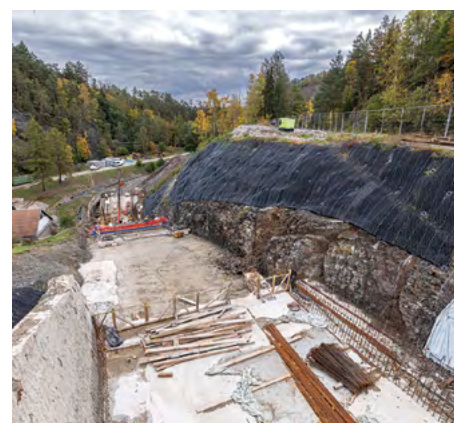
Betonáž skluzu a vývaru (říjen 2023)
