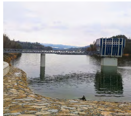
Hladina v nádrži se po rekonstrukci navyšuje (prosinec 2024)
