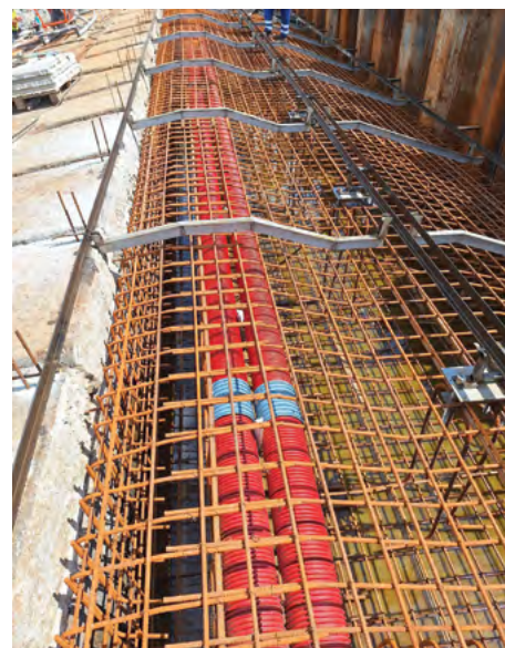
Výztuž předpolí s pomocnými konstrukcemi pro stahování betonu. Na výztuži jsou připraveny k zalití patky pro osazení provizorního hrazení, ve výztuži jsou viditelné chráničky pro případné propojení ovládání PK Mánes a PK Smíchov
