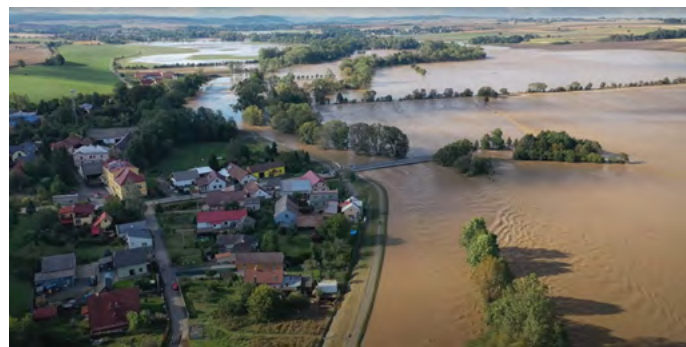
Obr. 3. Pravobřežní říční hráz v obci Holasovice za povodně v září 2024 obec ochránila
