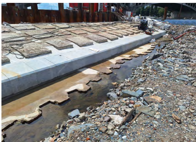
Prostor odtrhové hrany po dokončení stavebních prací
