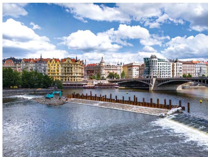
Dokončené práce na čtvrté etapě (před odřezáním štětovnic)
