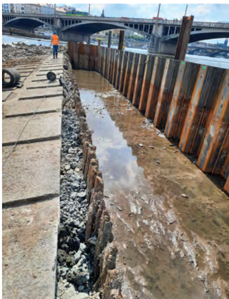
Vytěžený prostor předpolí s původními dřevěnými pilotami
