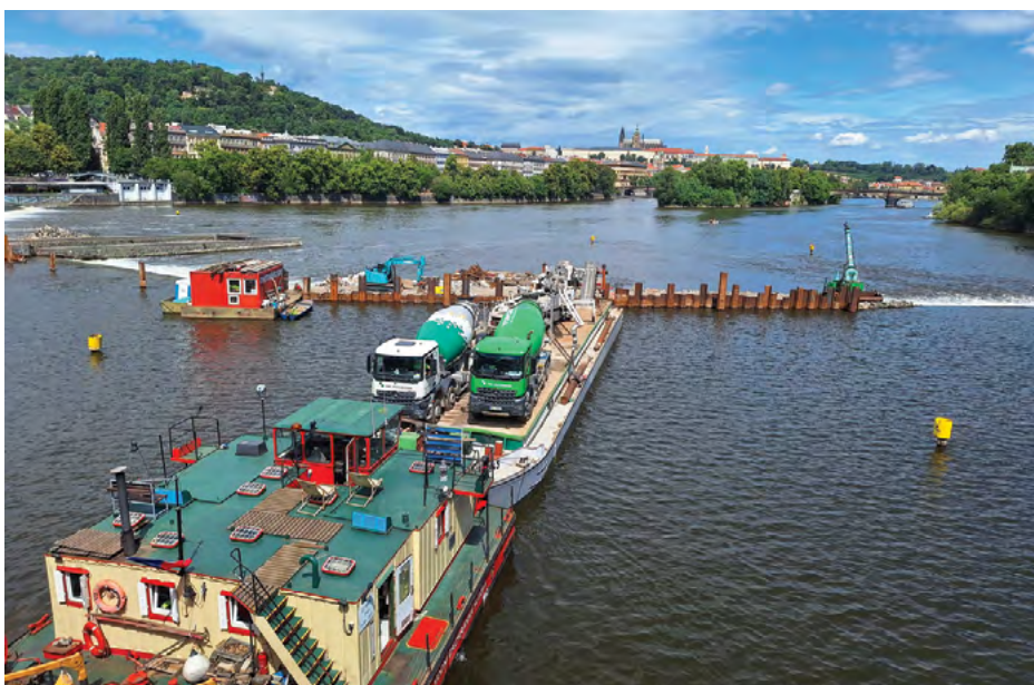
Betonáž z pontonu
