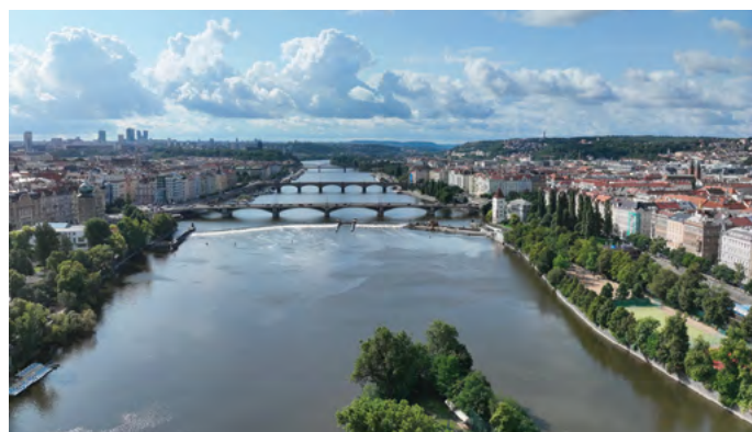
Pohled z dronu na Šítkovský jez, v pravé části probíhají stavební práce na I. etapě
