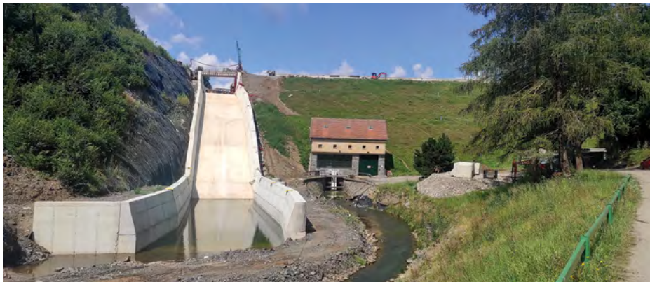
Pohled od vývařiště na betonový skluz od bezpečnostního přelivu (červenec 2024)
