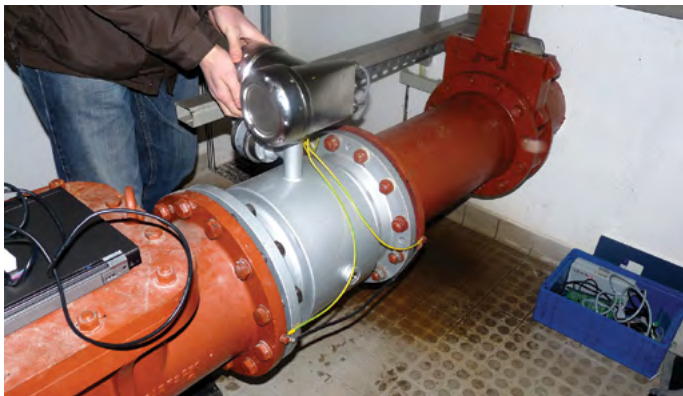
TIDALFLUX 2300 F při vypouštění do sdružené kanalizace
