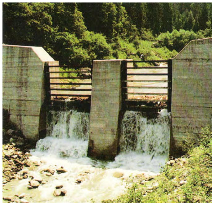
Nahoře: Otevřená přehrážka ze železobetonu slouží ke třídění splavenin a propouští jejich část do dolní tratě bystřiny (Gemmersdorferbach, 1999) [7]
