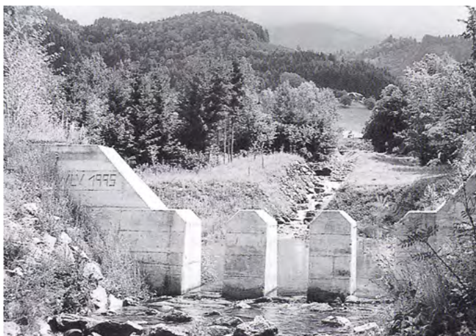
Nahoře: Otevřená přehrážka ze železobetonu slouží ke třídění splavenin a propouští jejich část do dolní tratě bystřiny (Gemmersdorferbach, 1999) [7]
